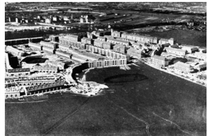
L: Erster Bauabschnitt vor Vollendung, 1926 (frei)
